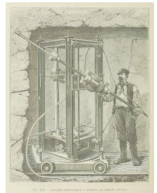
Der mit schwarzen Diamanten besetzte Leschot-Bohrer kam im 19. Jahrhundert beim Tunnelbau versuchsweise zum Einsatz. Die Maschine konnte sich durch hartes Gestein bohren.
